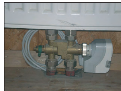
Bild 2. Vierweginjektionsventil am Energieabnehmer Quelle: Bälz
